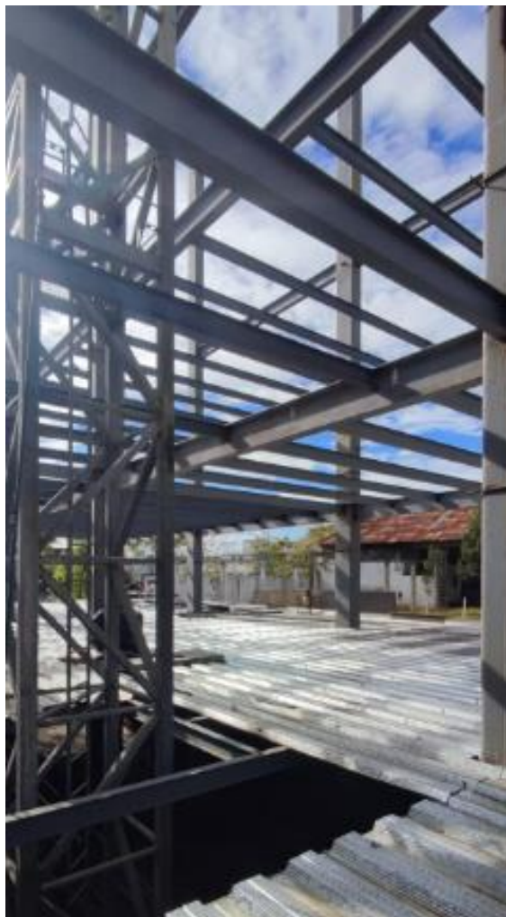
Ilustración 84 Avance de obra estructura metálica Julio 2022
