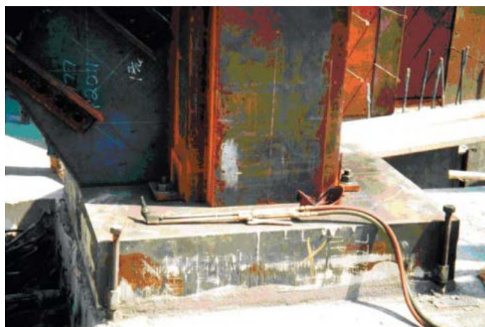
Figura 2.1.2: Placa base con tornillos de ajuste
