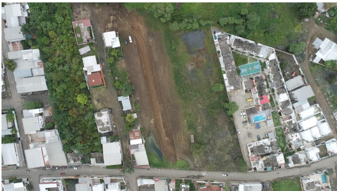
Ilustración 146: Acercamiento del terreno del proyecto. Fuente: Imagen captura con dron por el autor del caso.
