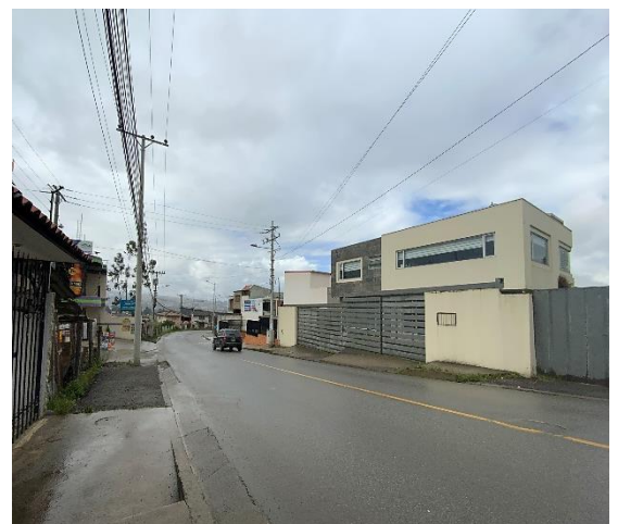
Figura 27. Estado de vía principal, Calle 1ero de Septiembre
