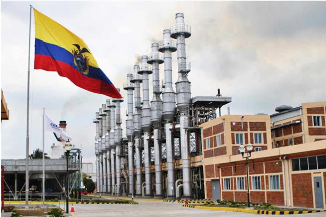
Ilustración 4: repotenciación de unidades de generación
