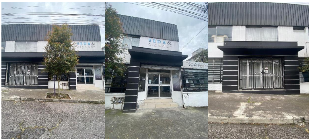
Anexo #3 Acceso estado actual inmueble
