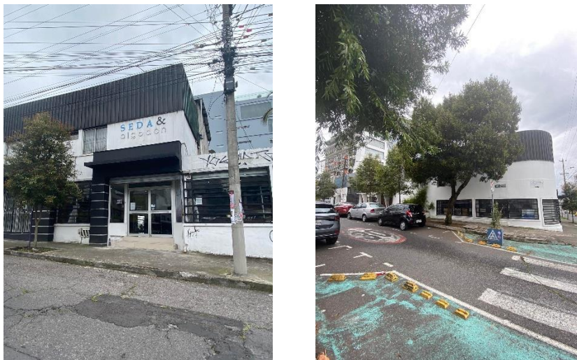
Anexo #8 Fotografías del estado actual del inmueble
