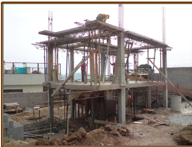
IMAGEN 3-1: COMPONENTE ESTRUCTURAL PROCESO CONSTRUCTIVO DE PORTICOS DE HORMIGÓN. FUENTE: Fernando Lara & Co. Dirección y Construcción de Proyectos Inmobiliarios, Mayo 2009. ELABORACION: Fernando A. Rueda.
