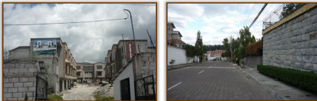
IMAGEN 2-5: CONJUNTO RESIDENCIAL BORDEAUX.
