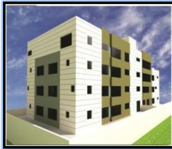
Ilustración 1-4 Esquina Sur - Oeste 3 Fuente: Cervantes & Asociados (Asociados, 2011) Realizado Por: Wilson Espinoza
