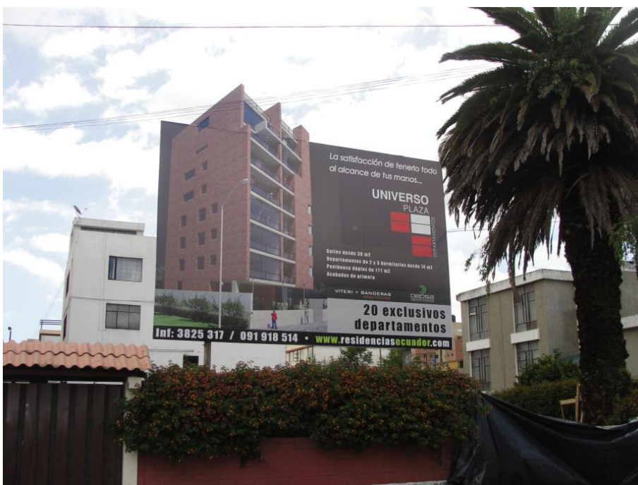
Imagen 2. 7 Fotografía del terreno (derrocamiento de la casa existente) Trabajos iniciales
