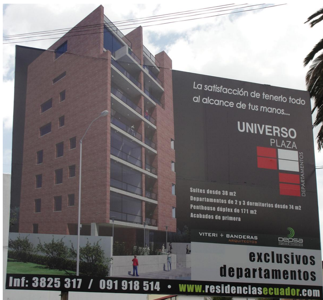
Imagen 6. 3 Valla en obra
