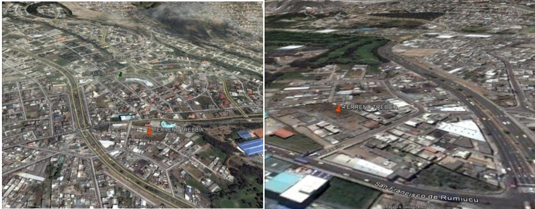
Fotografía 5: CARACTERÍSTICAS CONSTRUCTIVAS DEL SECTOR
