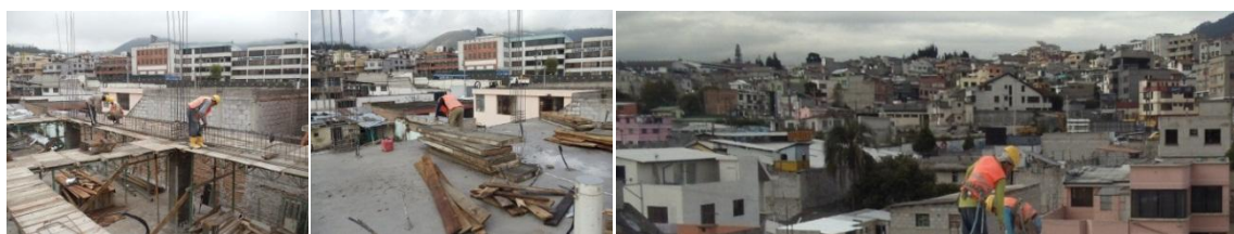
Fotografía 2: CARACTERISTICAS CONSTRUCTIVAS DEL SECTOR
