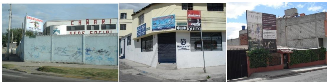
Fotografía 3: CARACTERISTICAS CONSTRUCTIVAS DEL SECTOR
