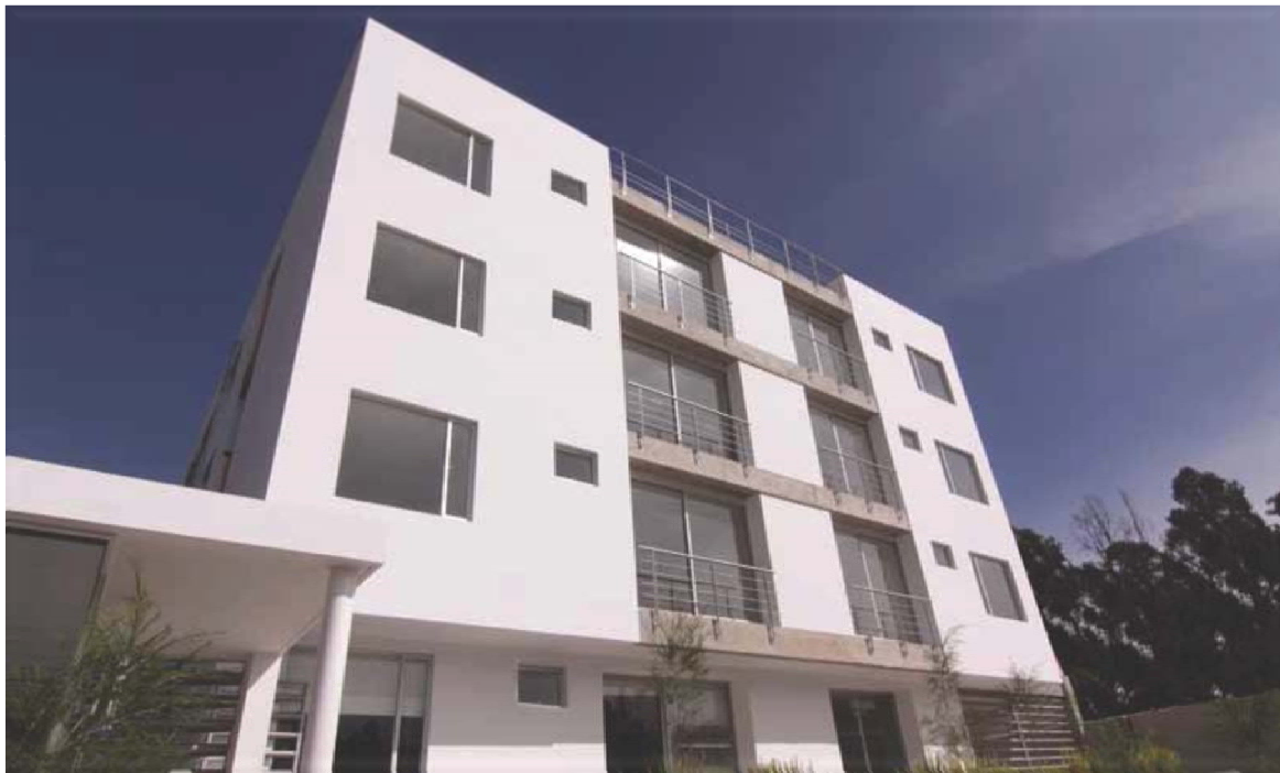
IMAGEN 4.5 FACHADA FRONTAL EDIFICIO LOS NARANJOS
