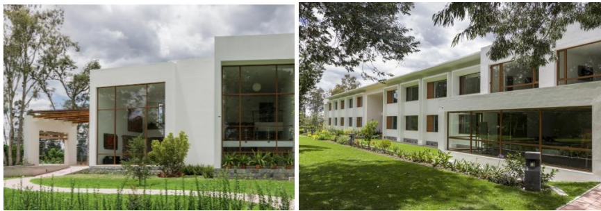
Ilustración 6 Edificio Bamboo San José de Puelmo
