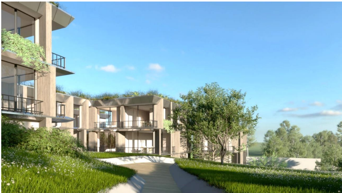
Ilustración 5.25 Vista Fachada Lateral Caminería Conjunto Aira; Elaboración: José Pablo González.
