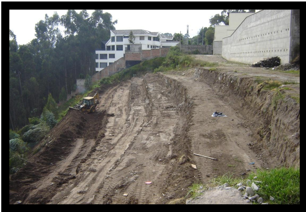
Gráfico 29: Vista Lateral del Terreno en proceso de desbanque [Elaborado por: autor]
