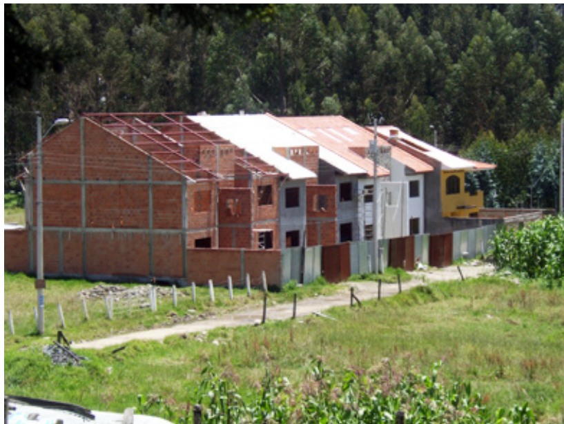
IIMAGEN 3-2: VISTA DEL PROYECTO EN EJECUCIÓN
