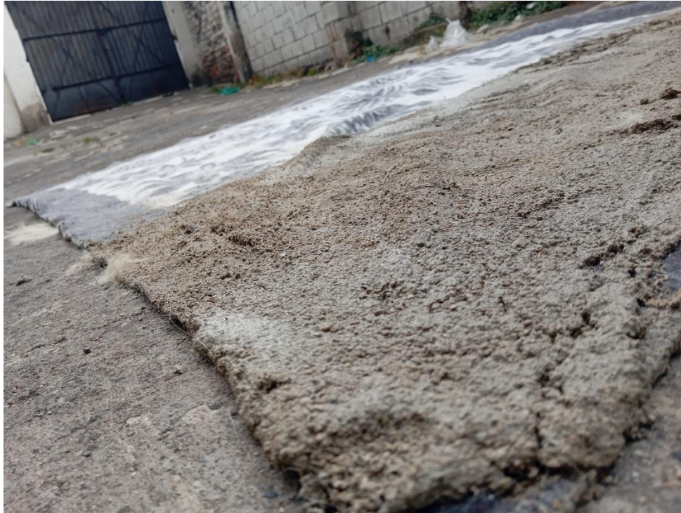
Figura 24. Detalle de la textura del mortero sobre la cobija.
