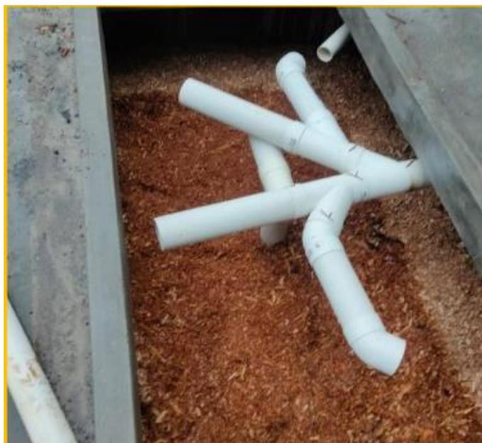
*Ilustración 3: Sistema de Vermifiltros*
