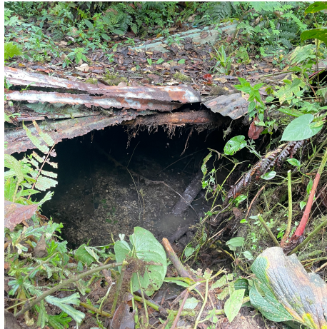
Ilustración 8 - Pozo séptico
