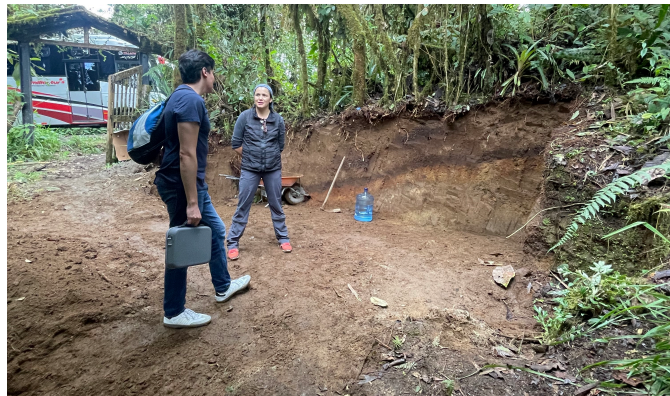
Ilustración 22 - Excavación para el tanque de infiltración
