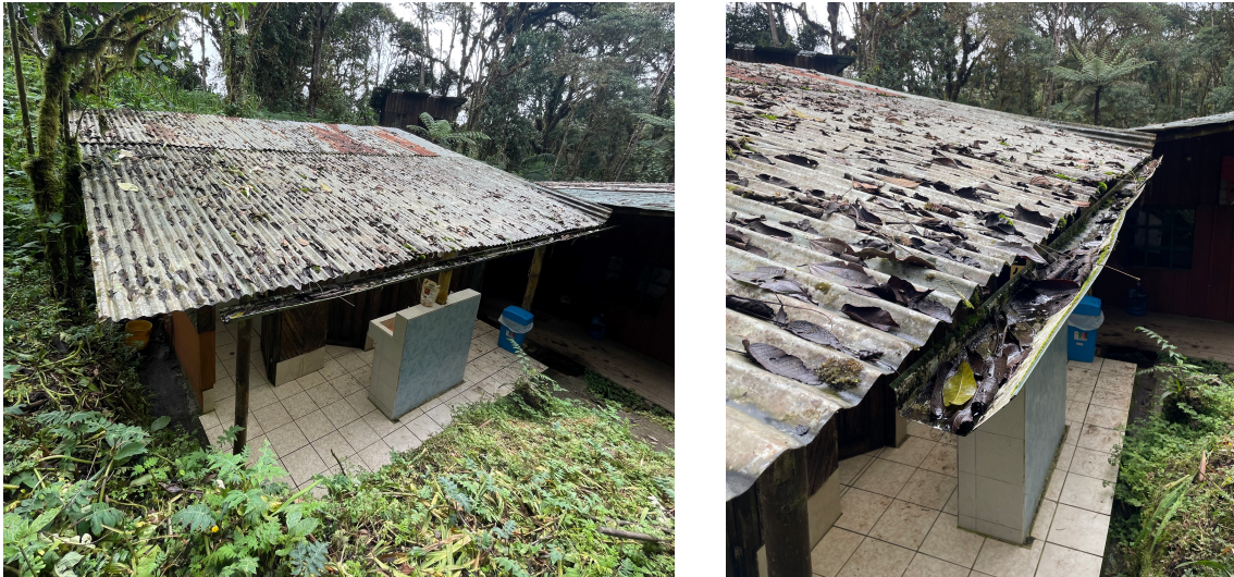
Ilustración 5 - Canaletas
