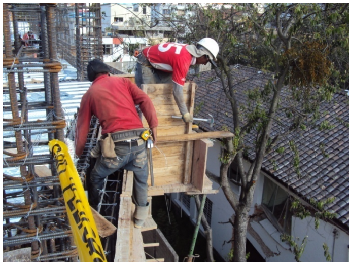
Imagen No. 5 Trabajadores de construcción - Edf. Rigel - nov.2011 Fuente: propia
