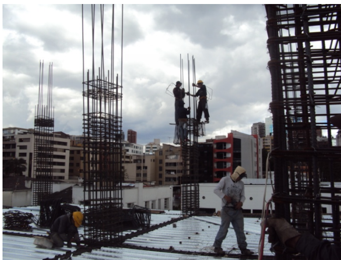
Imagen No. 2 Trabajadores de construcción – Edf.Rigel - sep.2011 Fuente: propia
