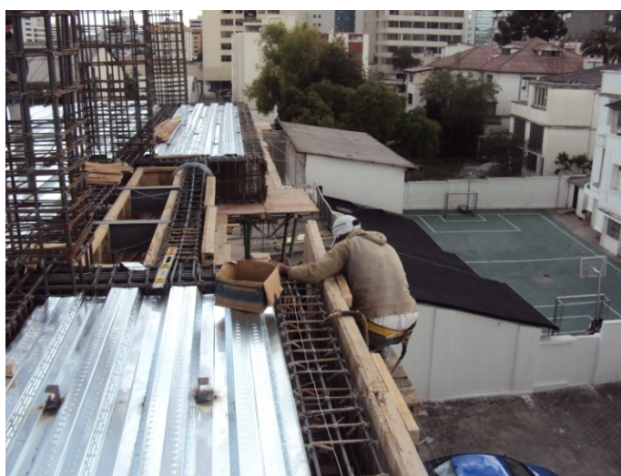
Imagen No. 4 Trabajadores de construcción - Edf. Rigel - oct.2011 Fuente: propia
