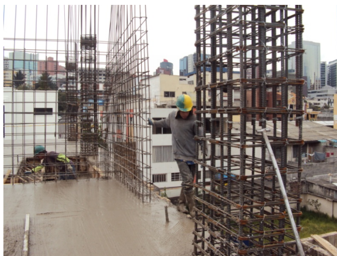
Imagen No. 1 Trabajadores de construcción – Edf.Rigel - sep.2011 Fuente: propia
