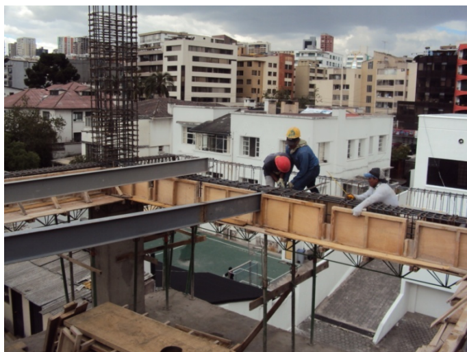
Imagen No. 3 Trabajadores de construcción - Edf. Rigel - oct.2011 Fuente: propia
