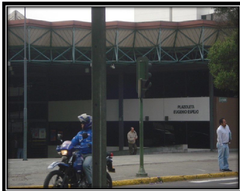
Imagen 6 EDIFICIO COLLEEN I Y II
