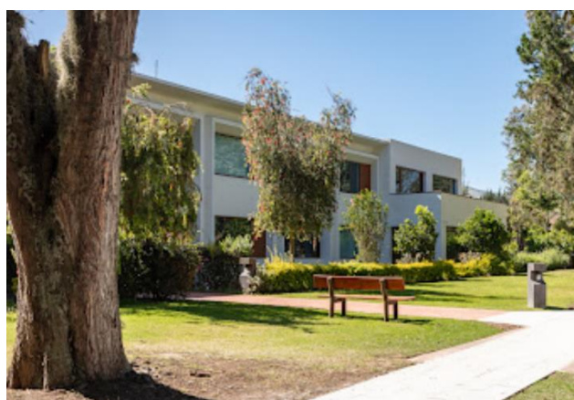
Figura 3 Estado actual hostería San José de Puenbo, Google image.
