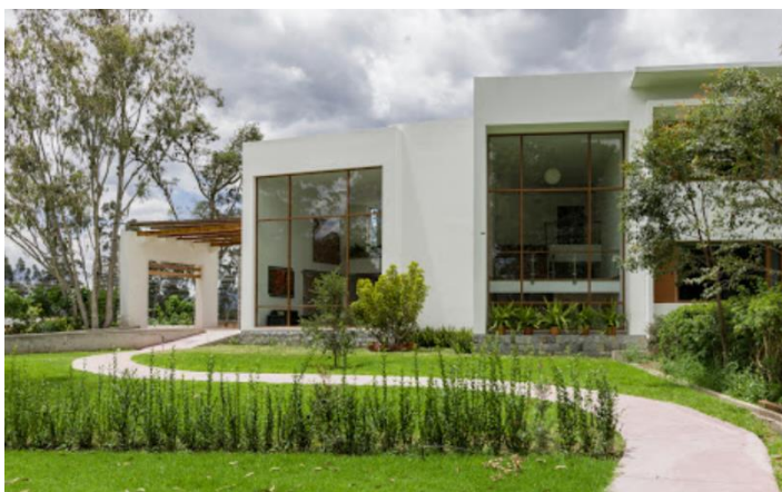
Figura 2 Estado actual hostería San José de Puenbo, Google image.
