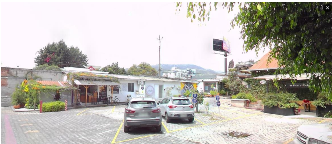
Figura 13- Vista Posterior 3 (Galpones Laterales)
