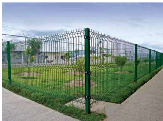
Figura 48. Cerramiento CercaPronto3D (IdealAlambrec)
