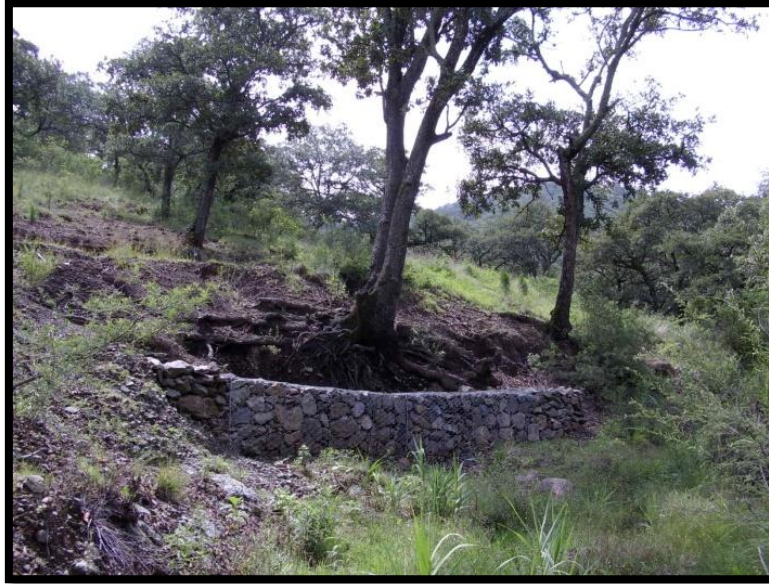
Figura 12.- Ejemplo de aplicación de Tecorrales actuando como un muro de gaviones
