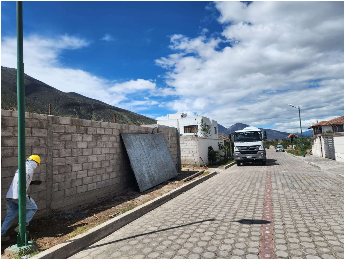
Fotografía 3: Calle S/N, frente del proyecto Canelo Gardens Fuente: Elaboración propia
