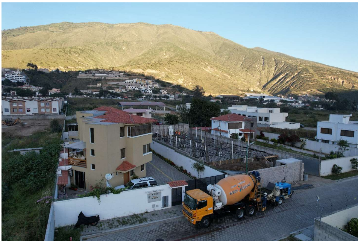
Fotografía 4: Proyecto Canelo Gardens y edificaciones aledañas Fuente: Elaboración propia
