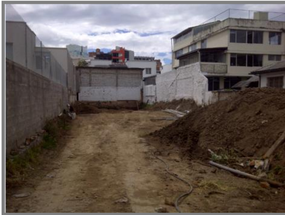
ILUSTRACIÓN 5. 1 - FOTOGRAFÍA DEL TERRENO PROYECTO EDIFICIO FRAGO FUENTE: FRAGO OCG. AUTOR. MARZO 2012 REALIZADO: AUTOR
