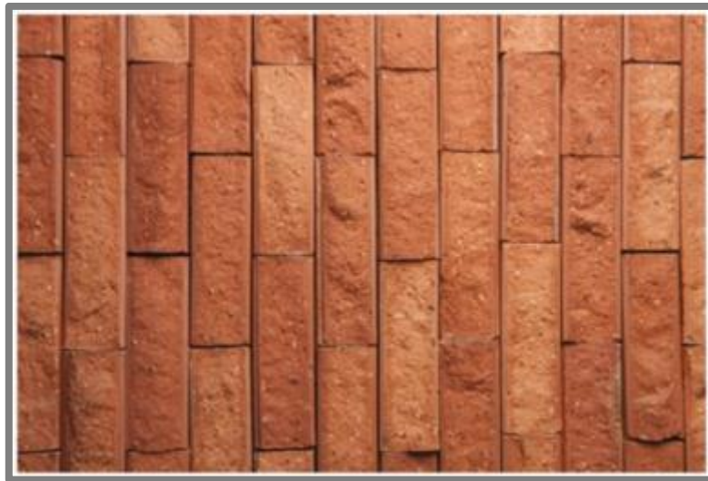
ILUSTRACIÓN 5. 17 – FOTOGRAFÍA TIPO DE ACABADO EXTERIOR FUENTE: FRAGO OCG. FEBRERO 2012 REALIZADO: AUTOR
