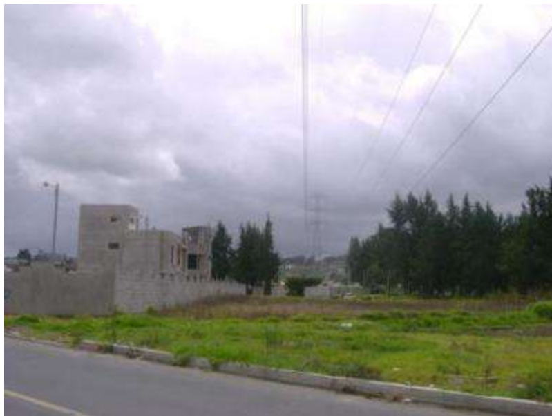
Fotografía 3.7. Red de Alta Tensión paralela al Conjunto Residencial El Pinar 2
