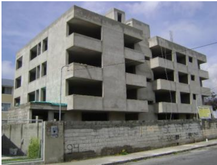
Ilustración 19 FOTOGRAFIA TOMADA EN SITIO DEL PROYECTO MILAN.
