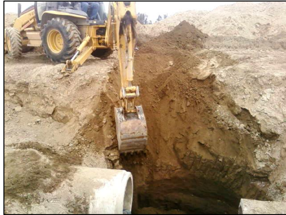
Fotografía No. 3 Excavación de Pozos Fuente: Elaboración Propia
