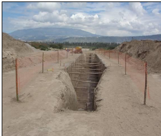
Fotografía No. 26 Rampa de acceso y salida de zanjas Fuente: Propia
