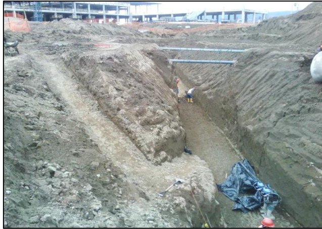
Fotografía No. 25 Rampa de acceso y salida de zanjas Fuente: Propia
