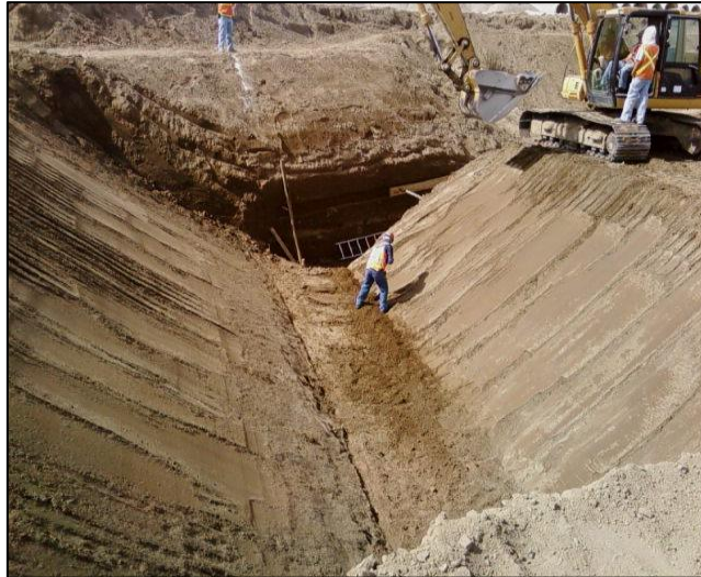
Fotografía No. 14 Pendiente adecuada y configuración de blindaje para suelos tipo C Fuente: Propia
