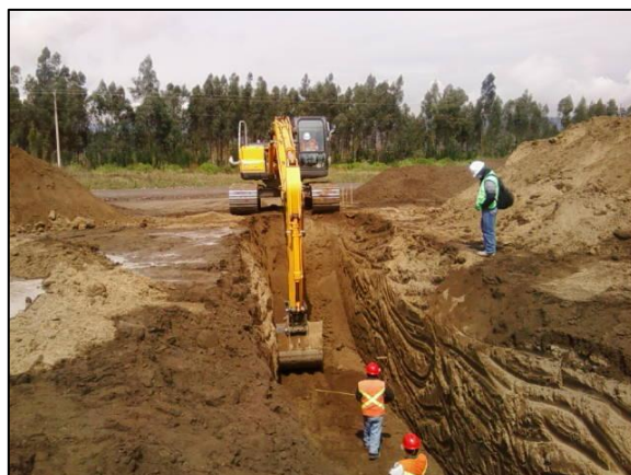
Fotografía No. 2 Excavación de Zanjas Fuente: Elaboración Propia
