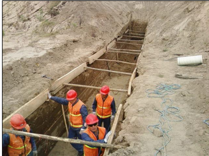
Fotografía No. 19 Sistema de apuntalamiento con Entibado Horizontal Fuente: Propia
