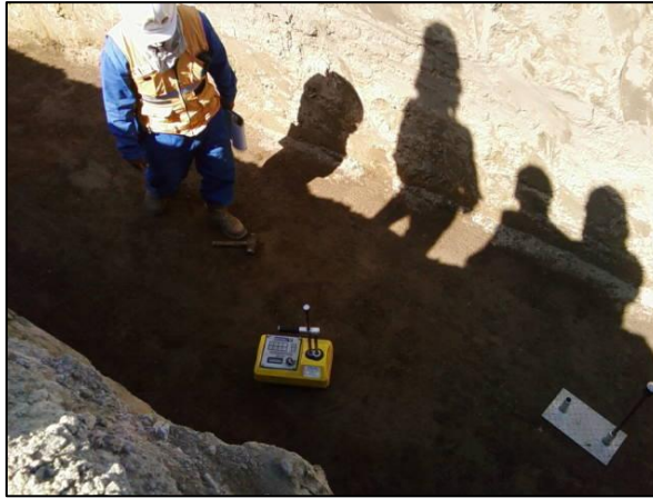
Fotografía No. 5 Comprobación de Compactación Fuente: Elaboración Propia
