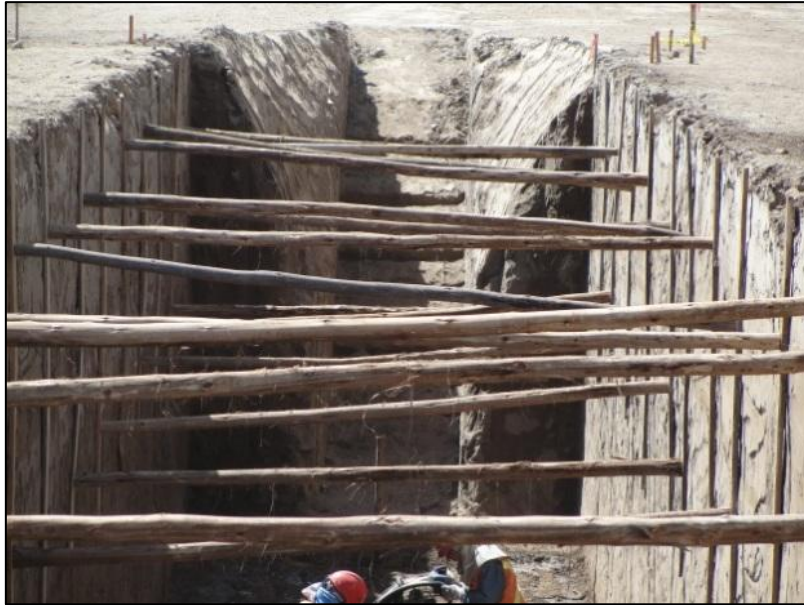
Fotografía No. 20 Sistema de apuntalamiento con Entibado Vertical Fuente: Propia
