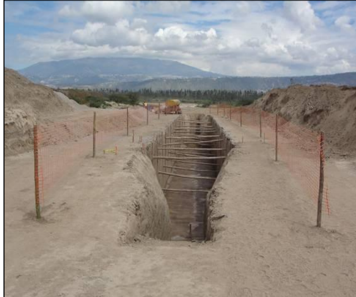
Fotografía No. 30 Cercado de Zanja Fuente: Propia
