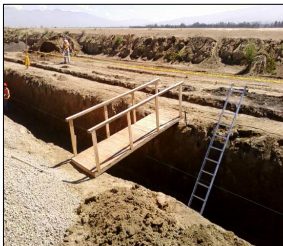
Fotografía No. 28 Pasarela Fuente: Propia
