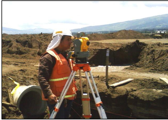
Fotografía No. 1 Trabajos de Topografía Fuente: Elaboración Propia
