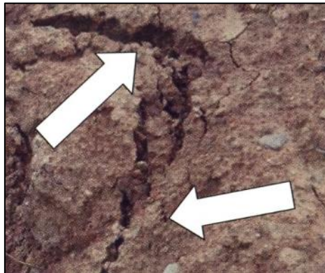
Fotografía No. 12 Grieta de Tensión
