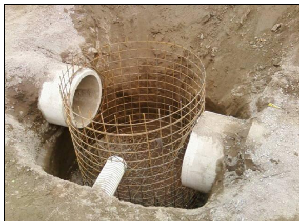
Fotografía No. 9 Armado Estructural de Pozos Fuente: Elaboración Propia
