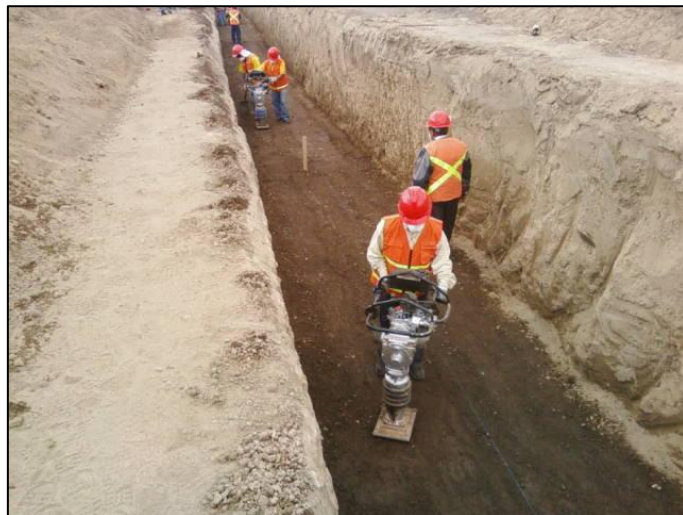
Fotografía No. 4 Compactación de Zanjas Fuente: Elaboración Propia
