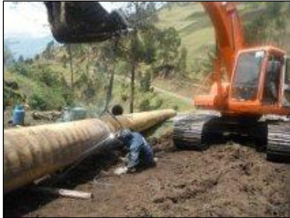
Fotografía No. 8 Instalación de Tubería Fuente: Elaboración Propia
