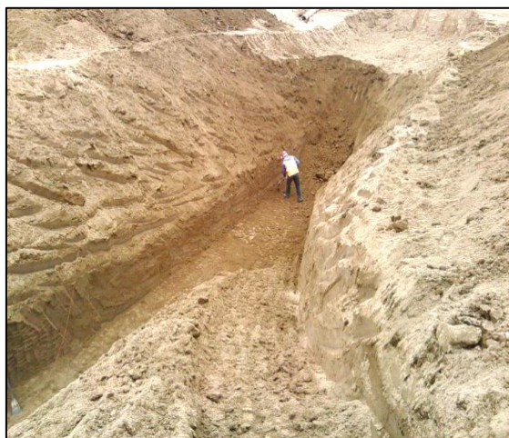
Fotografía No. 27 Rampa de acceso y salida de zanjas Fuente: Propia
