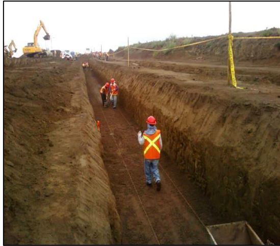
Fotografía No. 22 Colocación de Escombros Fuente: Propia
