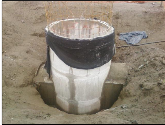
Fotografía No. 11 Pozo fundido Fuente: Elaboración Propia
