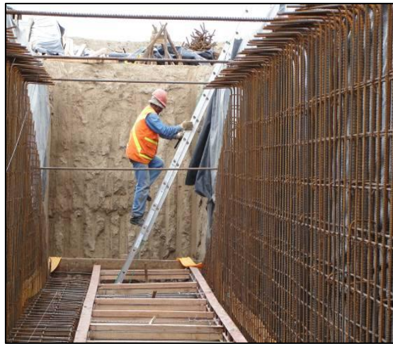
Fotografía No. 24 Escalera al interior de zanja Fuente: Propia
