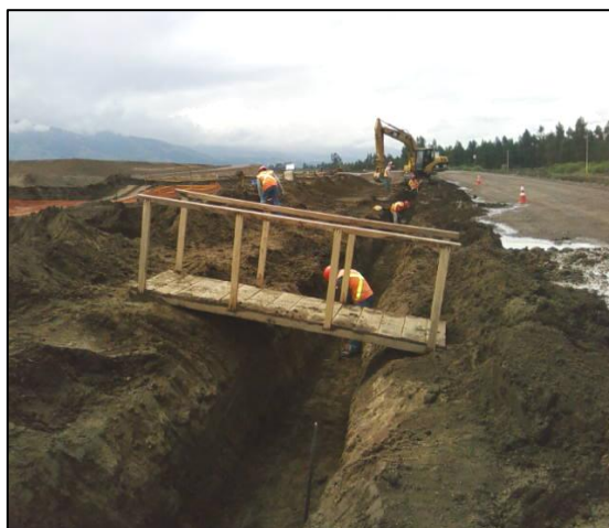
Fotografía No. 29 Pasarela Fuente: Propia
