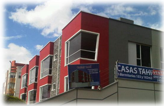
Fuente: Ingeniero Paredes
