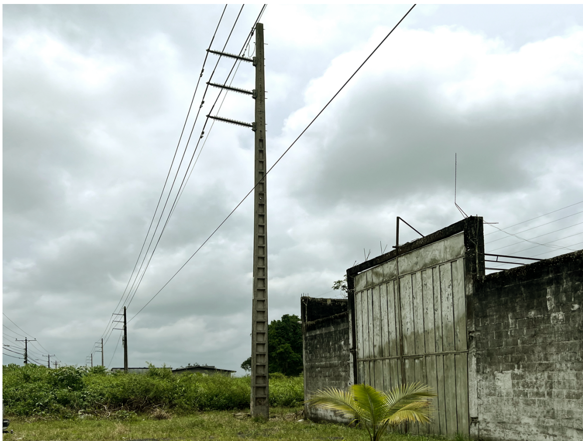
Ilustración 27 Tendido de Línea de Media Tensión Fotografiado por: Jean Torrico
