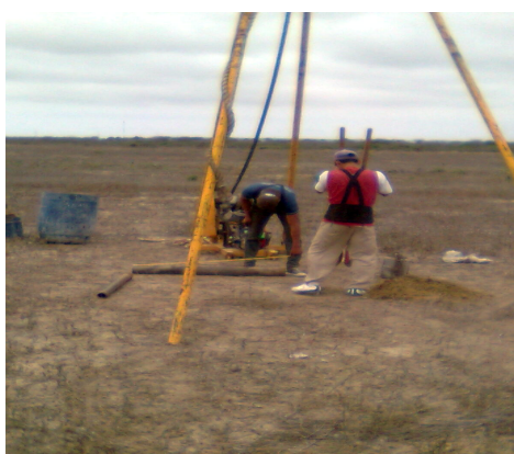
Figura # 41: Toma de muestras para el estudio de suelos
