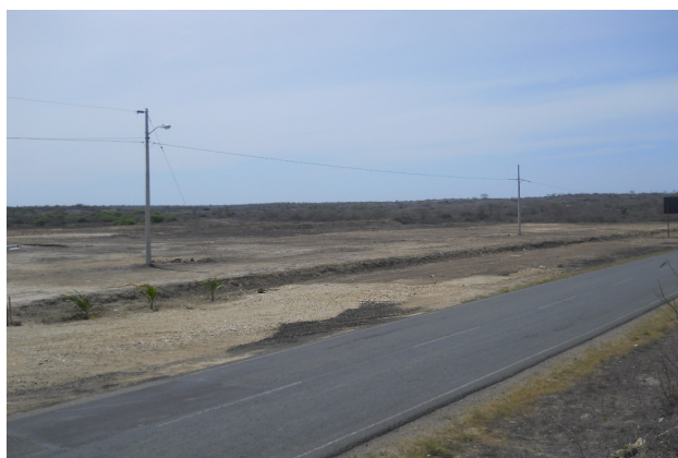
Figura # 44: Colocación de postes y transformador
