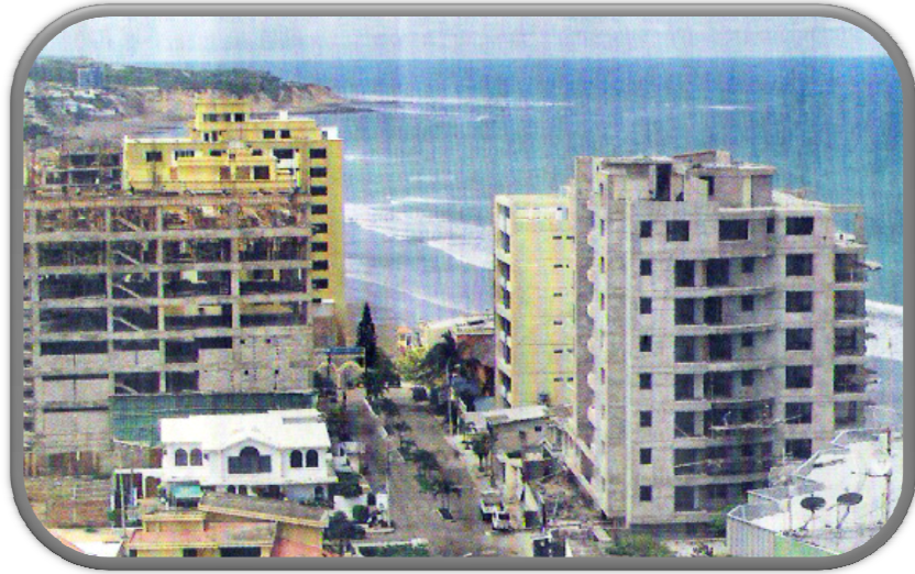
IMÁGEN 0.8 Edificios que se levantan simultáneamente en Playa El Murciélago
