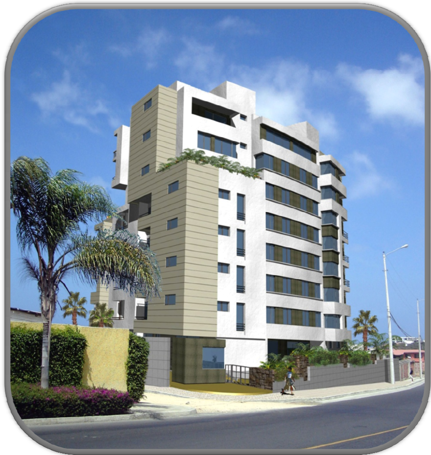
IMÁGEN 0.5 Vista de fachada oeste
