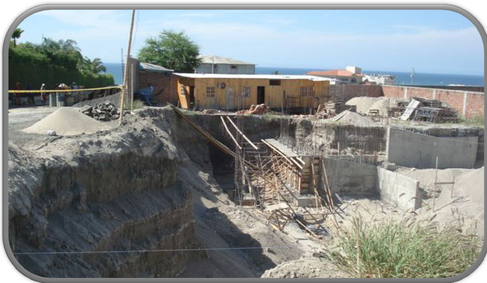
IMÁGEN 0.5 Estado actual del proyecto
