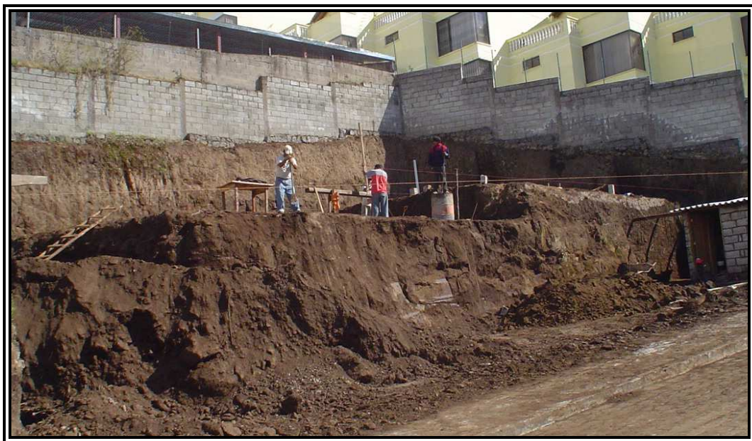
Imagen 4. 12 Terreno donde se construirá el Edificio Madyson
