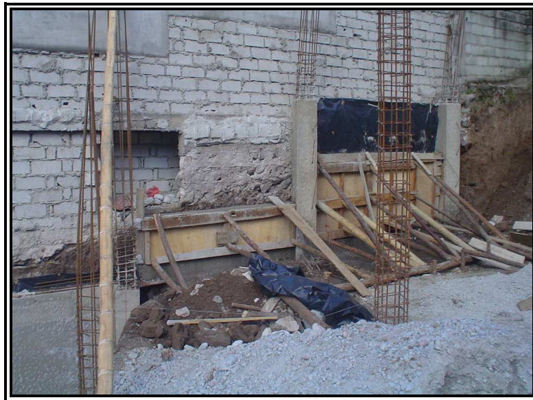
Imagen 4. 14 Construcción de Muros y levantamiento de columnas
