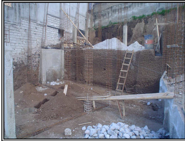
Imagen 4. 13 Construcción de Muros y levantamiento de columnas
