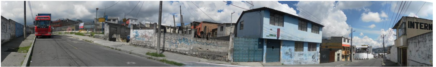
Ilustración66: Fachada posterior del terreno
