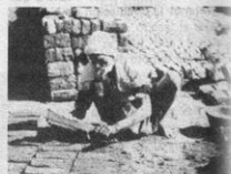
FIGURA 158: SE RETIRA EL MOLDE PARA COMENZAR OTRO LADRILLO
