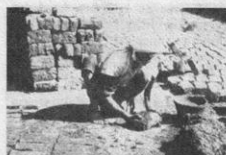
FIGURA 155: LA TIERRA SE AMASA EN FORMA DE BOLA sas dobles rectangulares trenzadas con hojas de palmeira y recubiertas
