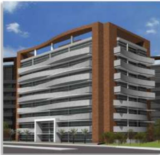
Ilustración 3-6: Fotografía edificio Catalina Park Fuente: viviendaexpress.com MDI, 2012
