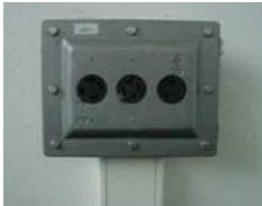
Figura 5-4: Tomas de corriente multipolares de uso industrial
