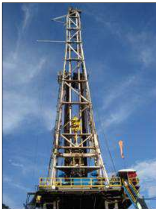
Fotografía No. 9. Torre de perforación RIG H&P 121
