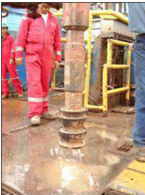
Fotografía No. 6. Personal de Halliburton supervisando el proceso de perforación.
