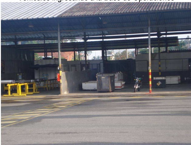
Área de Mantenimiento y Sperry.
