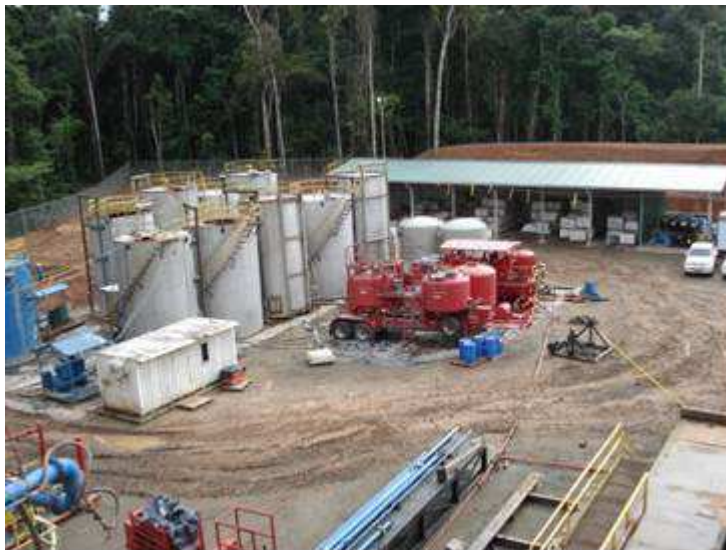
Fotografía No. 7. Vista panorámica, se divisa los tanques verticales para almacenar aguas de perforación, bodega de química y unidad de cementación.
