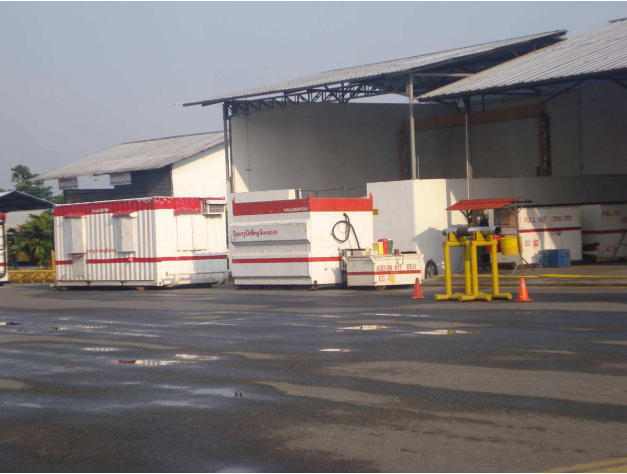
Equipos de Sperry
