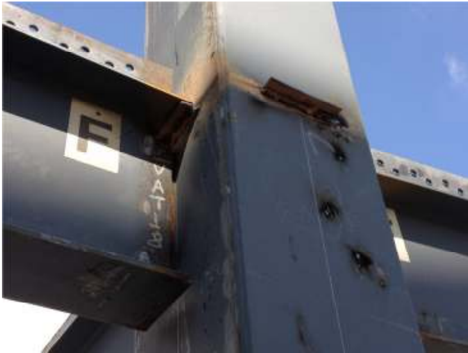
Figura 28. Conexión viga-columna exterior de edificio en construcción de Empresa 1
