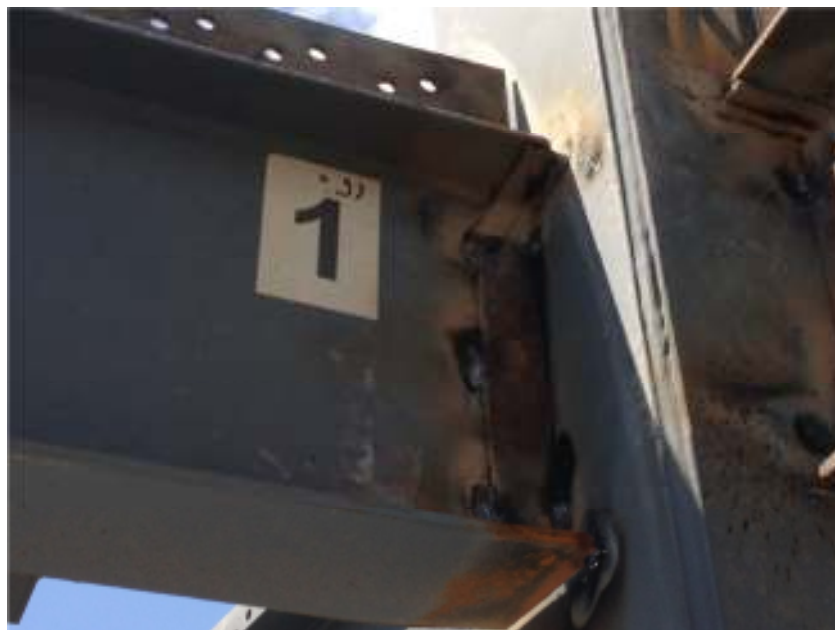
Figura 26. Montaje de vigas y columnas en edificio visitado de la Empresa 1
