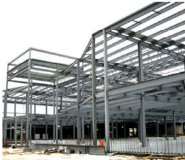
Figura 2. Pórtico Especial de Acero Resistente a Momento (PEARM)
