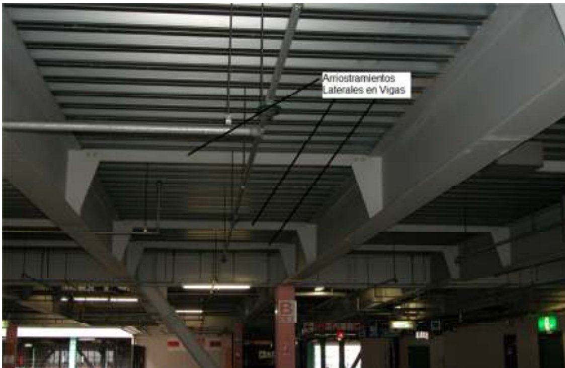
Figura 14. Ubicación de arriostramientos laterales en vigas (Engelhardt, 2007)
