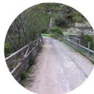
PUENTE DEL CHAQUINAN
