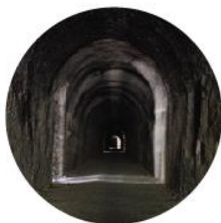
TUNEL DEL CHAQUINAN
