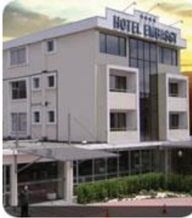
Gráfico 1. Vista exterior del edificio
