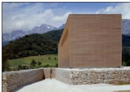
21: Uso de materiales in situ
