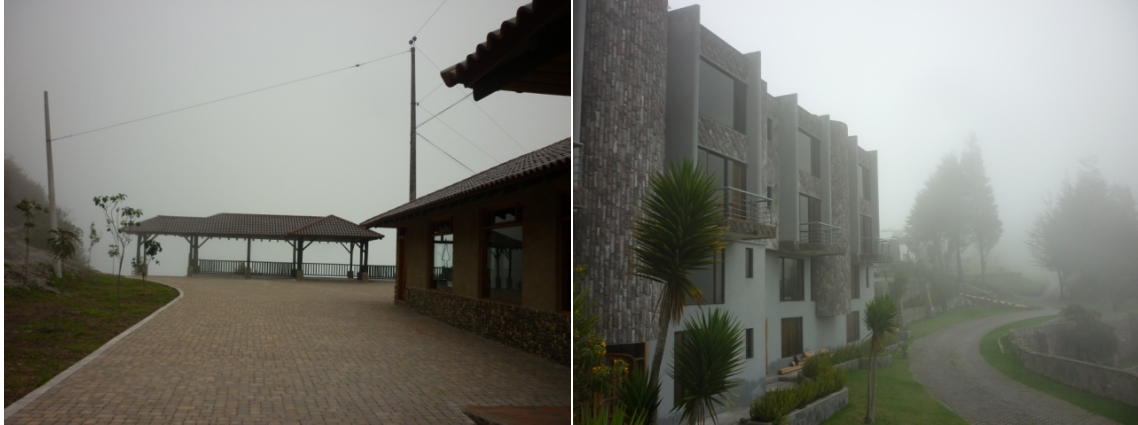
Imágenes tomadas en mirador y edificio Hostal / restaurante existentes
