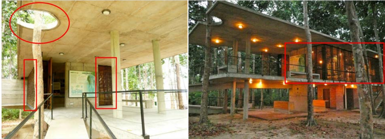
Imágenes de puntos permeables en losa y tratamiento permeable de paredes
