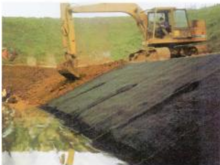
Ilustración 25. Protección de márgenes con Enkamat 720
