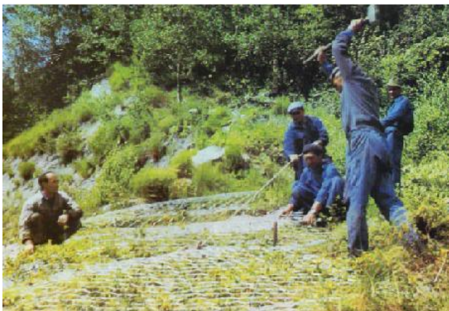
Ilustración 27. Colocación de anclajes
