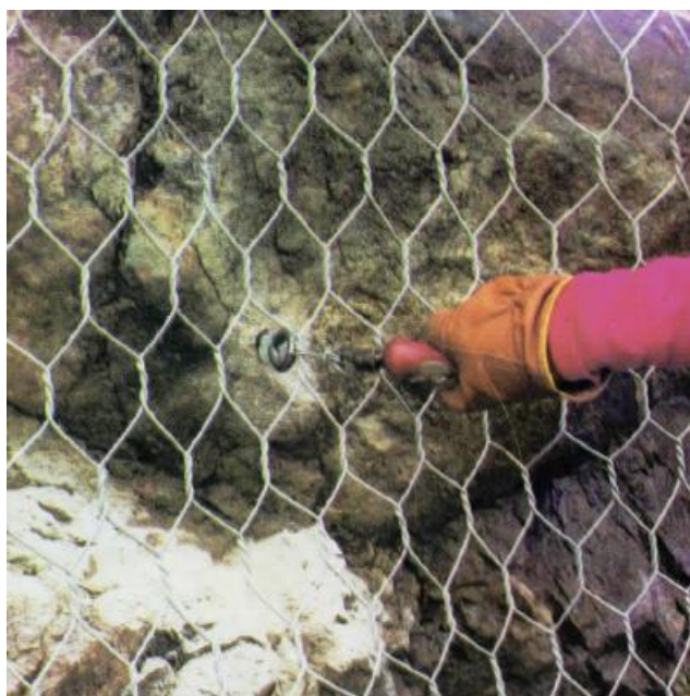
Ilustración 28. Colocación de anclajes a lo largo de la pared
