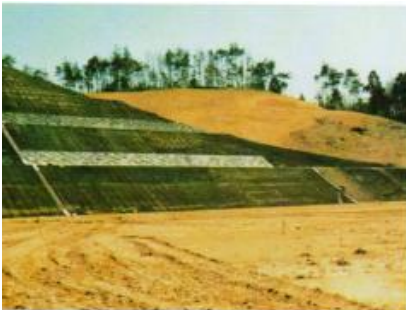
Ilustración 24. Protección talud de terraplén
