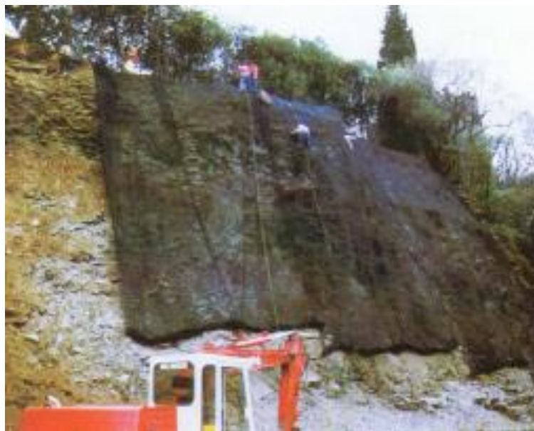
Ilustración 26. Protección pendiente con MacMat-R
