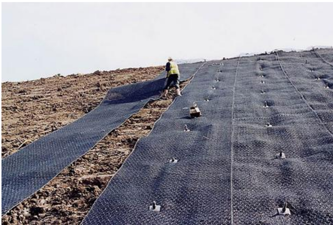
Ilustración 41. Protección con geomanta
