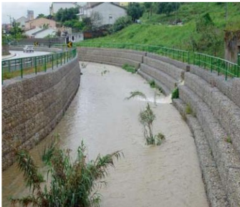
Ilustración 17. Muro de gaviones
