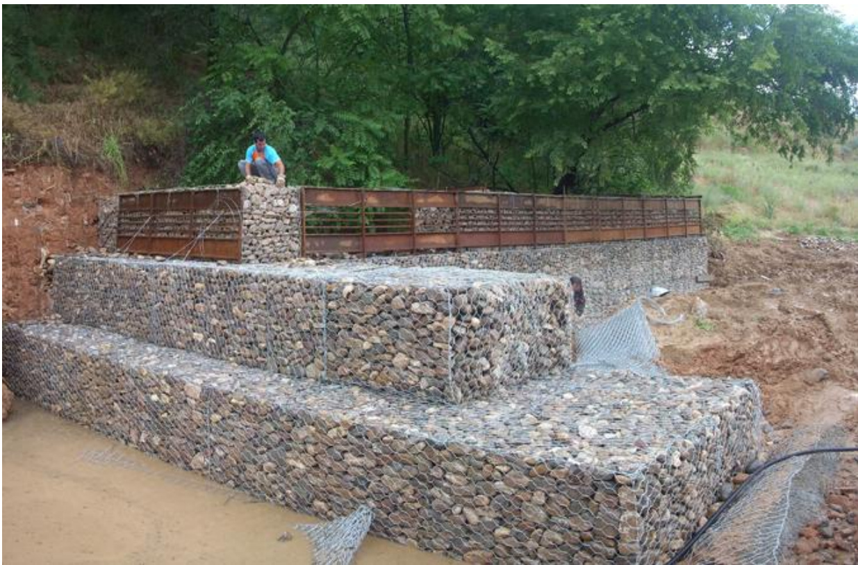
Ilustración 35. Muro de Gaviones
