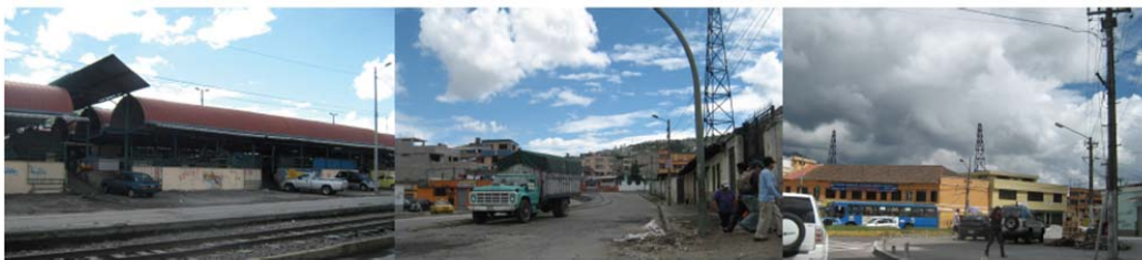
Fig. 57 En la actualidad el sector se encuentra con alto deterioro, escaso espacio público y altos índices de delincuencia.
