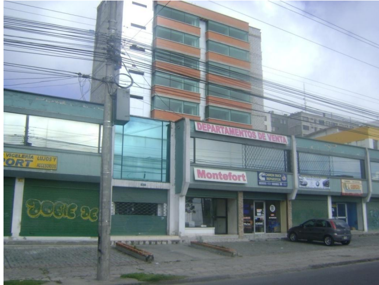
Fotografía 3-4 Proyecto Montefort Tomado por: Erick Bermeo Bonilla
