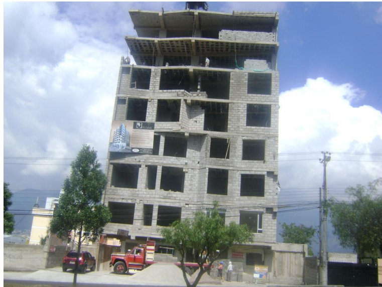
Fotografía 3-3 Proyecto Edificio Juliana Tomado por: Erick Bermeo Bonilla
