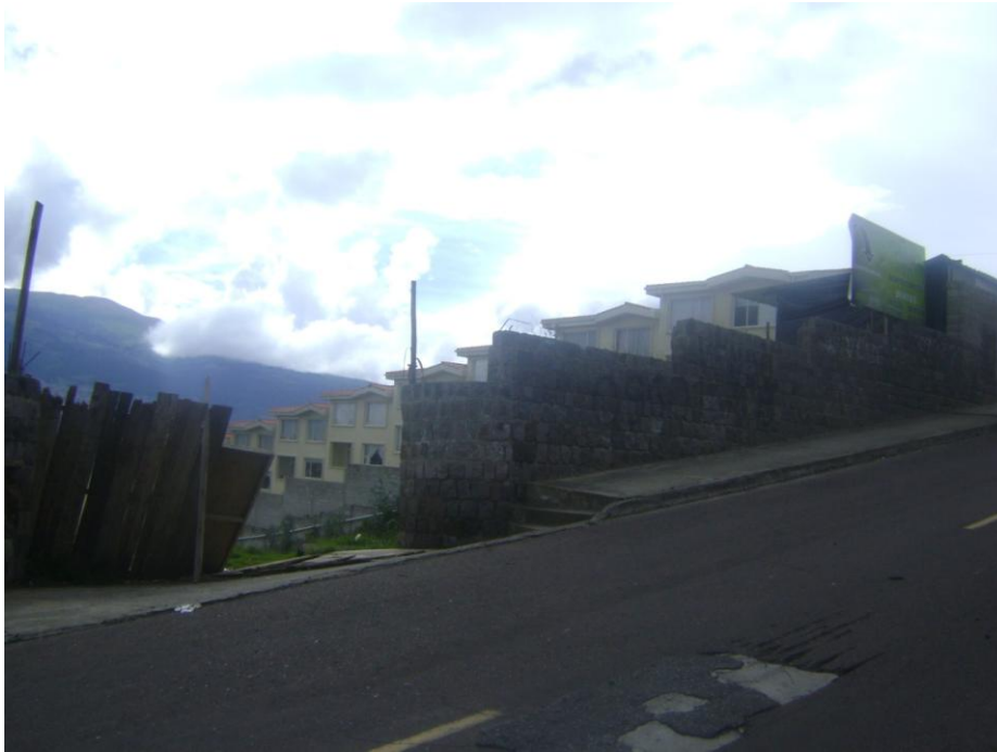
Fotografía 4-2 Terreno Proyecto Toulouse Cerramiento Frontal – Sector Santa Lucia Alto
