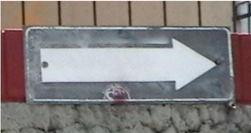
Ilustración 42 Señal Vertical deteriorada e ilegible ubicada en la calles Quijano y Ordoñez y Calixto Pino.
