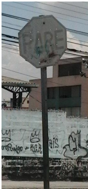
Ilustración 10, señalización vertical deteriorada
