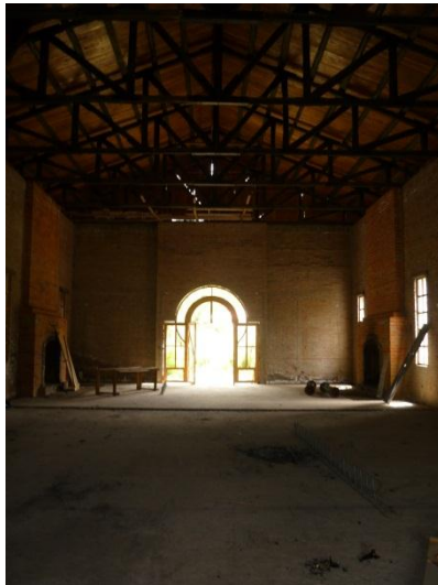
Estado actual de Vestíbulo y Recepción
