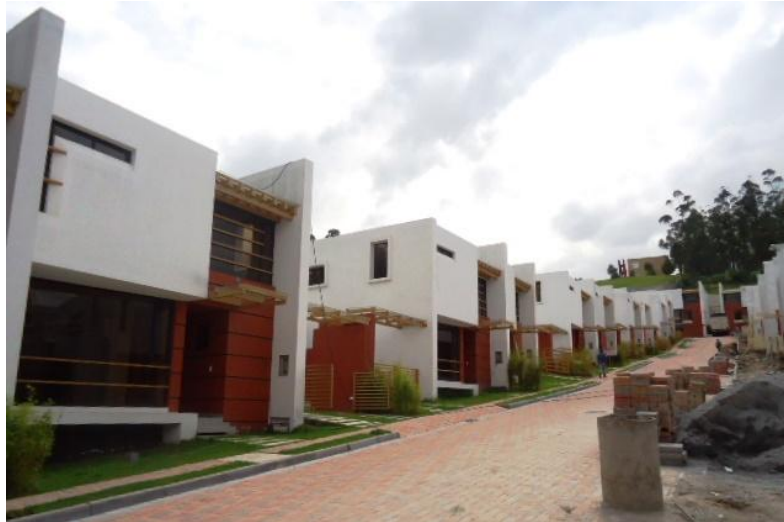
Fotografía 4: Interior Conjunto Villa Orellana
